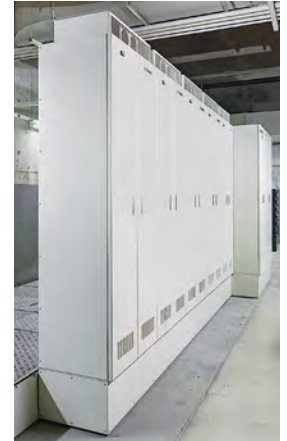
受電盤・分岐主幹盤・ 調光器盤・調光制御盤 改修
