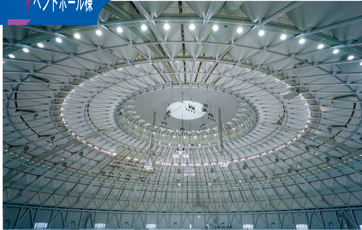
イベントホール棟 内部
