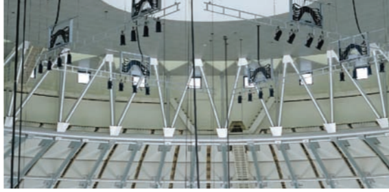
イベントホール棟 天井部
