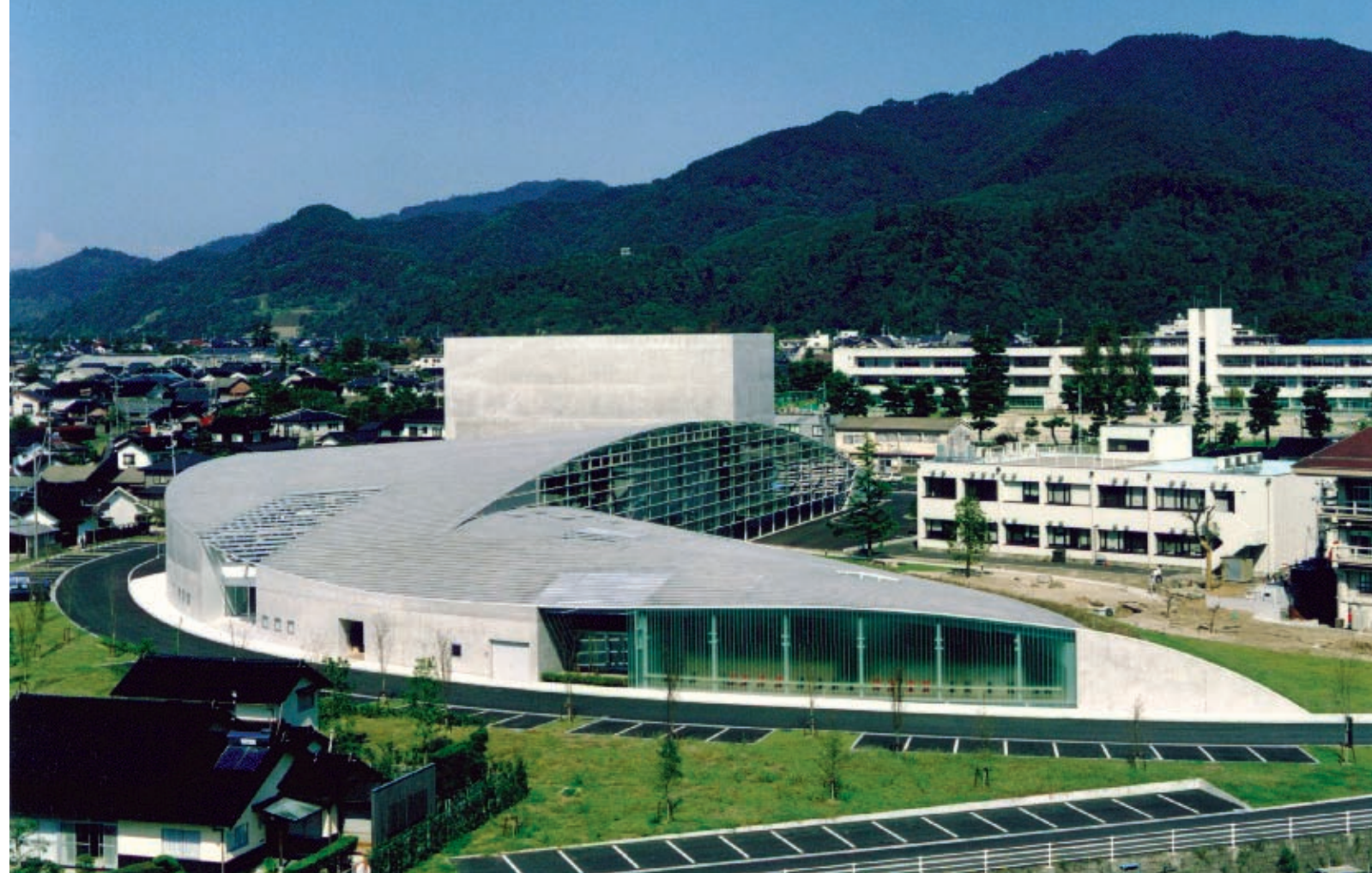
舞台照明設備 施工 (だんだんホール) (ごえんホール)
