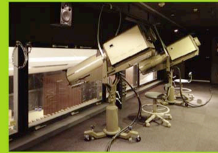
ピンスポットライト(2kWキセノン)
