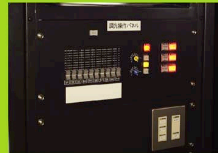
調光操作パネル(機構操作盤組込)
