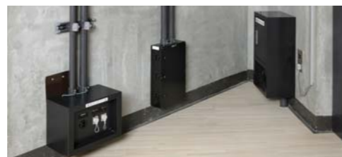
■舞台袖DMX信号コネクタ盤(新設)・舞台前コンセント盤(新設)
