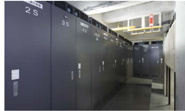
■主幹盤・分岐主幹盤・調光器盤 (取替)
