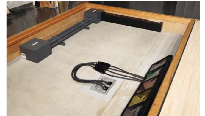
■舞台後コンセントボックス (新設)
