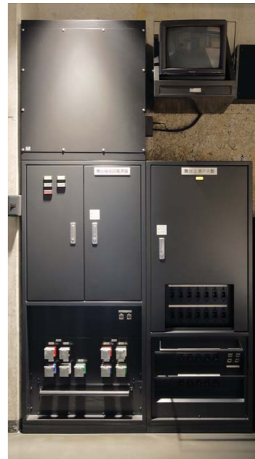
■舞台袖PA盤 (右・新設) ■舞台袖仮設電源盤 (左・新設)
