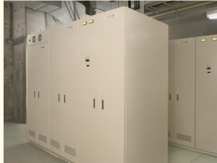
19 主幹盤・分岐主幹盤・調光器盤 更新
