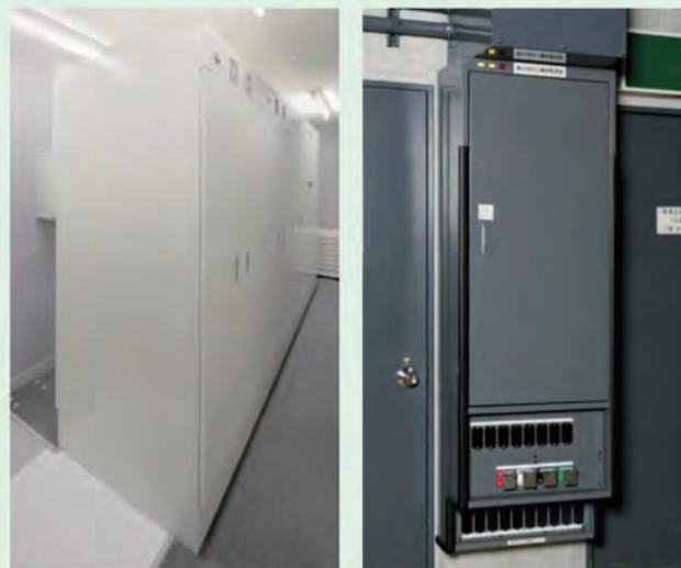
20 主幹盤・調光器盤 交換
