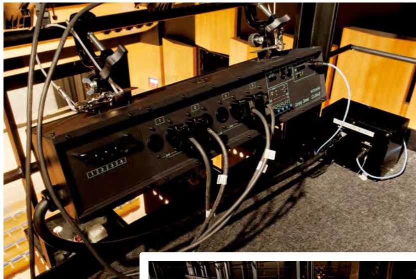
主幹盤・調光器盤・直負荷盤
