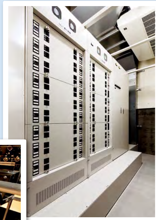
主幹盤・調光器盤・直負荷盤
