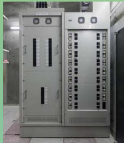
調光器はインテリジェント調光システム「IDU」を導入。調光システムをすべてデジタル制御にすることで、調光出力など調光器毎のバラつきがありません。また、負荷電流、負荷漏電検出、配線用遮断器(MCCB)状態、調光器温度などの調光器個々の情報を一括管理。調光室に設置した調光監視システムにより監視が可能です。
