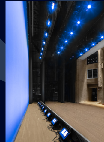
LEDアッパー・水平ライト [交換] LEDロー・水平ライト [交換]
