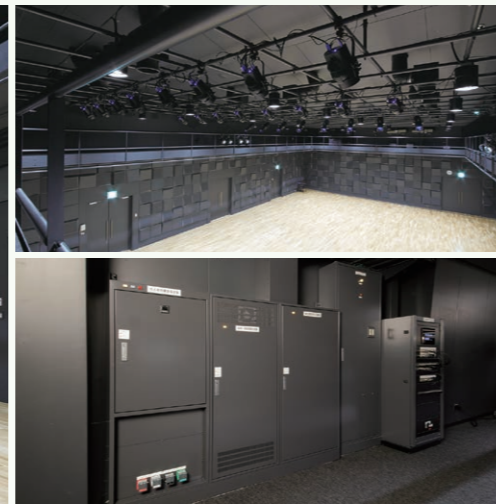
持込照明機器電源盤/客席一般照明調光器盤/ 演出照明用分電盤/DMXパッチラック
