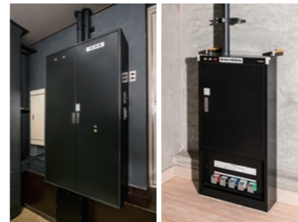
主幹調光器盤 新設 舞台袖持込機器用電源盤 新設
