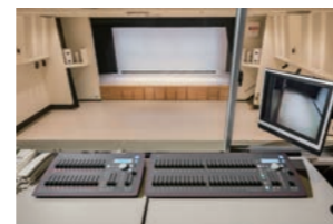
■ 照明操作卓 交換 記憶シーン数 576メモリー コントロールチャンネル 96ch
