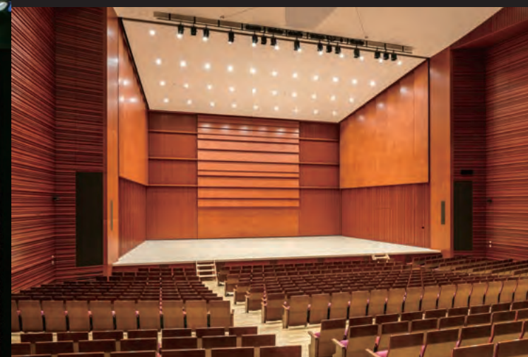
CR-W-LED II -500 (42灯設備) / ハロゲン電球500W相当の明るさ / 定格消費電力83W / 広角タイプ
