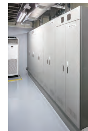
主幹盤・負荷分岐盤・調光制御盤・ 調光器盤・客席用調光盤
