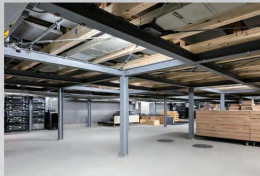
移動形調光器接続盤を奈落に配置。舞台空間の機能性を最大限に引き出せる様に保ち、優れた静粛性を確保
