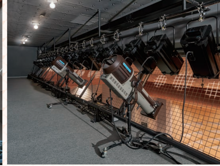
シーリングライト 改修 新設 ・ フォロースポットライト 更新 ※
