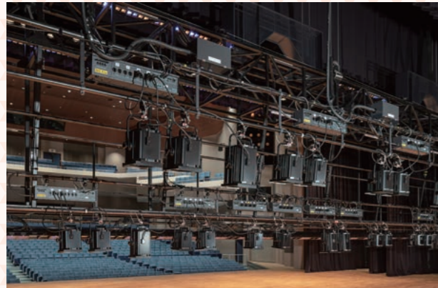
サスペンションライト 改修 ※
