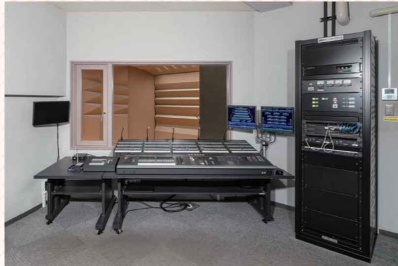
調整室ネットワークラック 改修 ※
