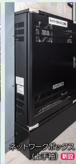
主幹盤・演出照明用電源盤 更新 LED照明制御盤 新設
