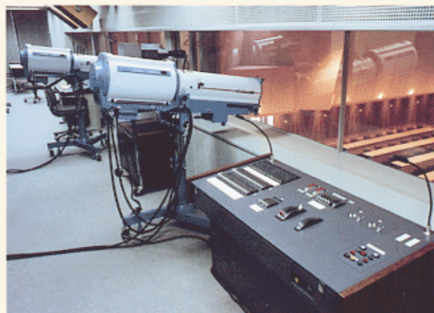
照明操作卓、 Sun Beam 1 クセノン1kW
