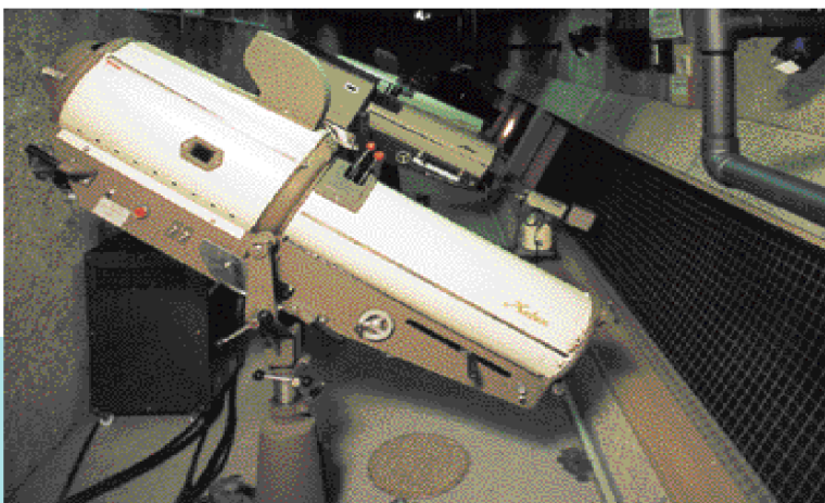
第2シーリングスポット室(センターフォロースポットライト)
