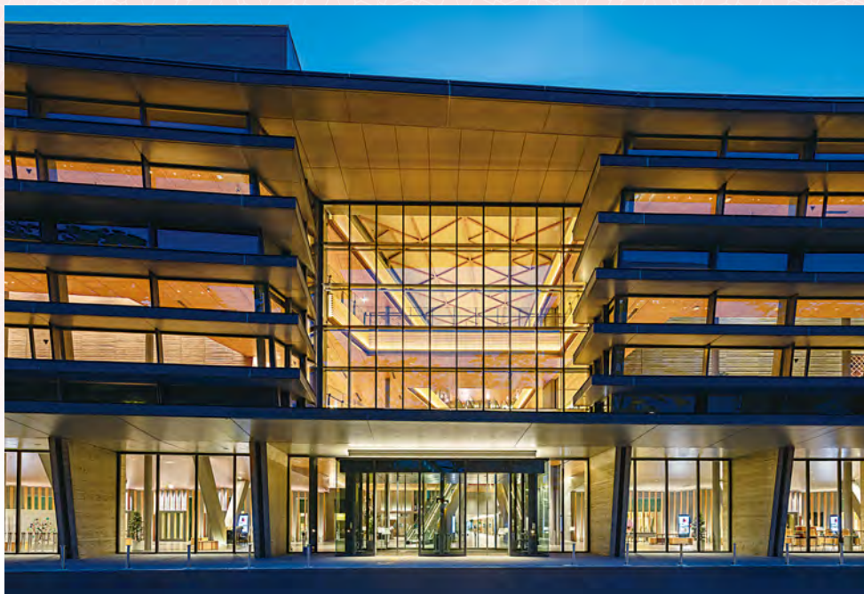
外観エントランス 夕景
