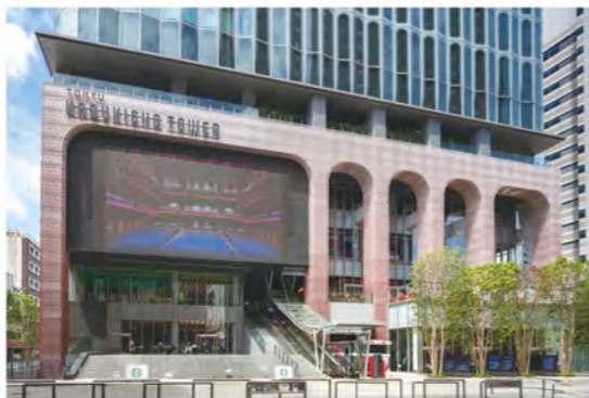
エントランス(シネシティ広場側)
